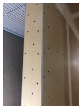
100～150mmピッチ 左右少しずらして固定
